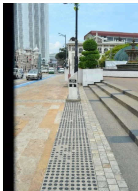
Rajah 11 Pemasangan tactile blok betul di bawah Kawasan tangga di sekitar Dataran Merdeka (Sumber: Azhar, 2024)
